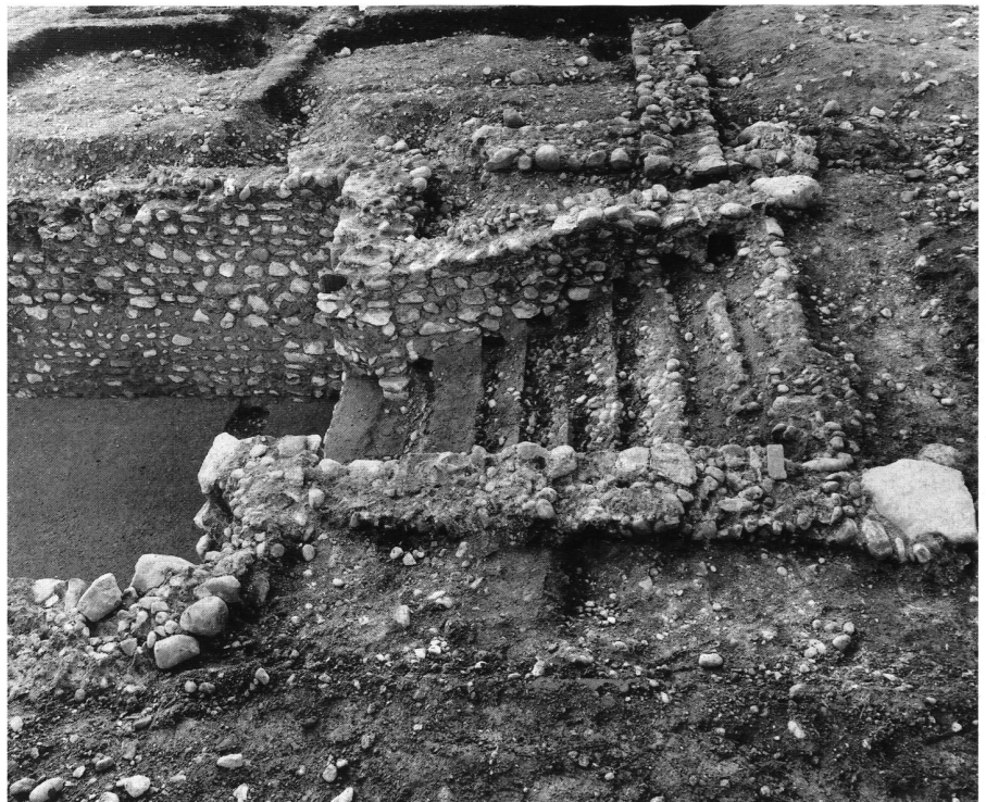
17: Ansicht der Kellertreppe von Osten.
