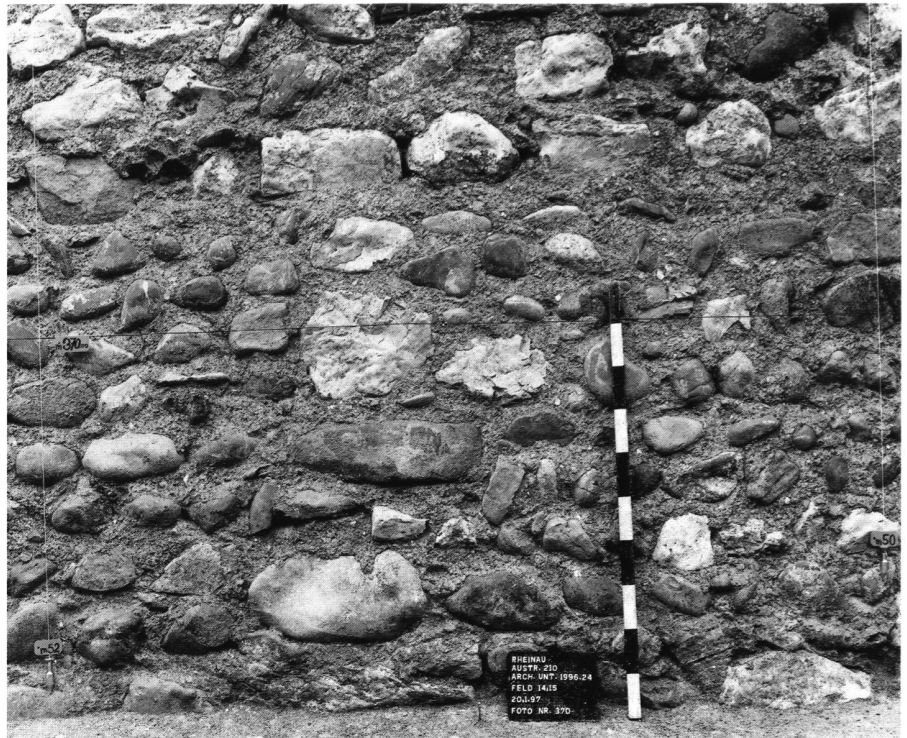
16: Kellermauer mit säulenartiger Steinstütze im Bereich der Unterfangung.
